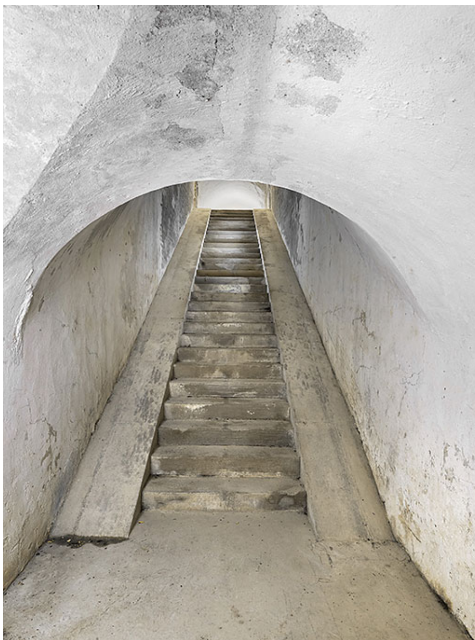
Escalier-rampe, vue montante.
