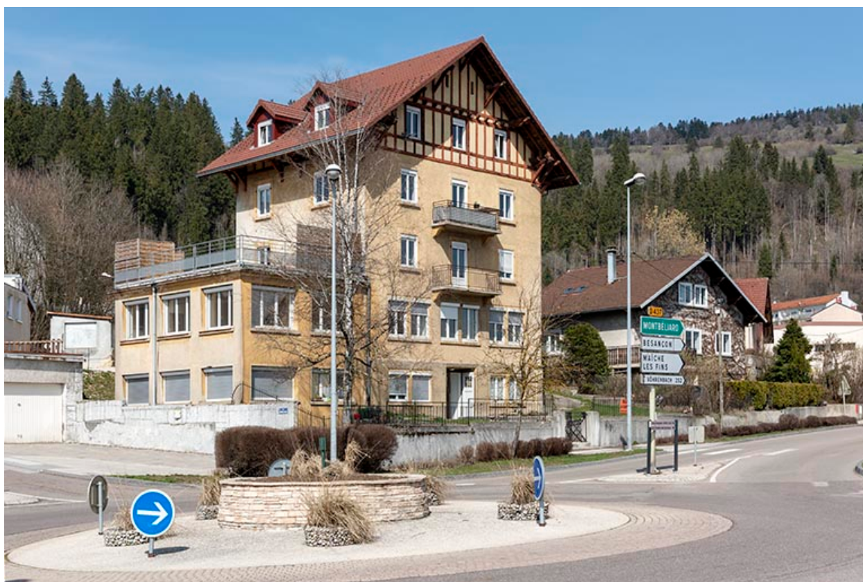
Façades antérieure et latérale gauche, en hiver.
