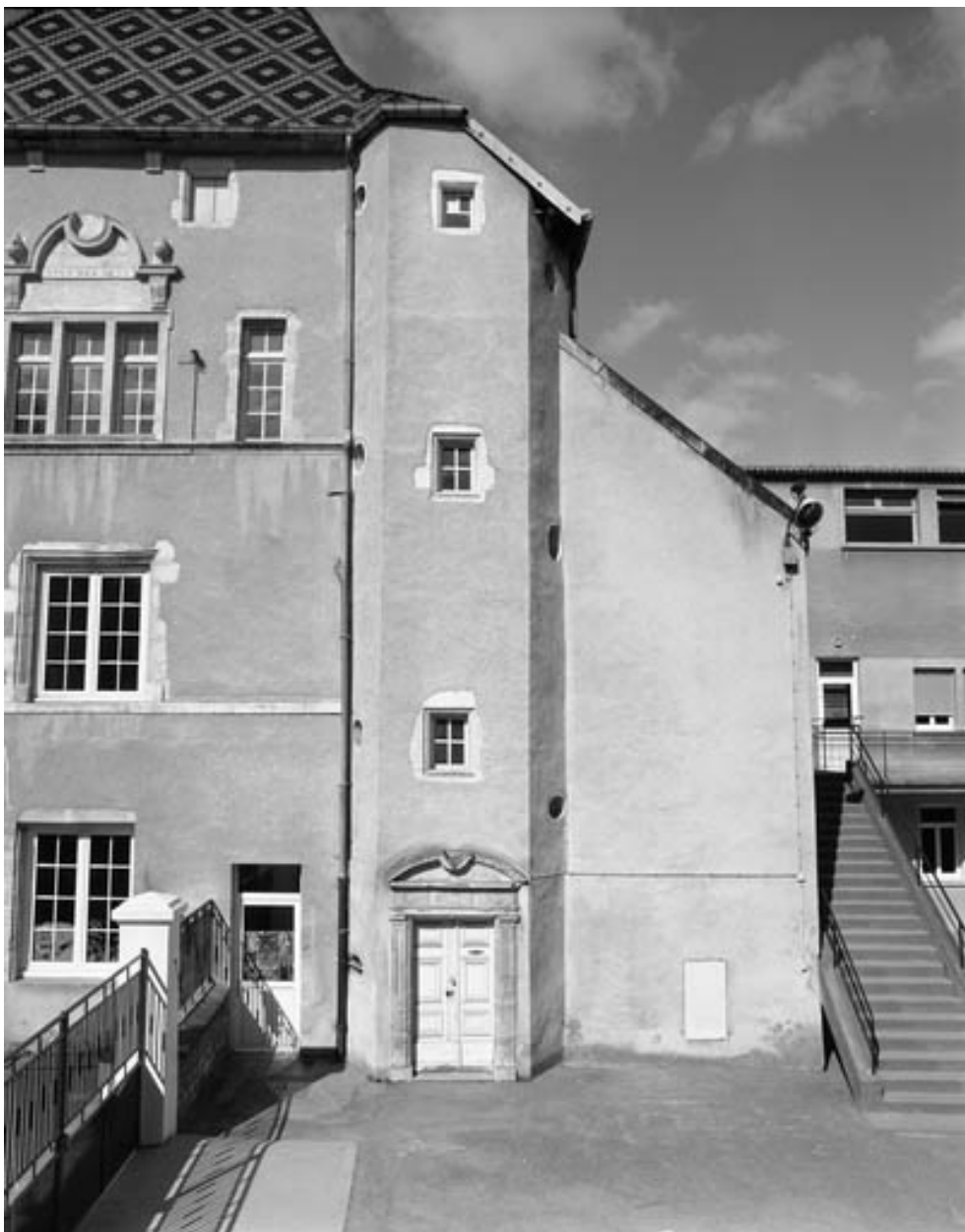
Détail de la tour d'escalier, de face.
