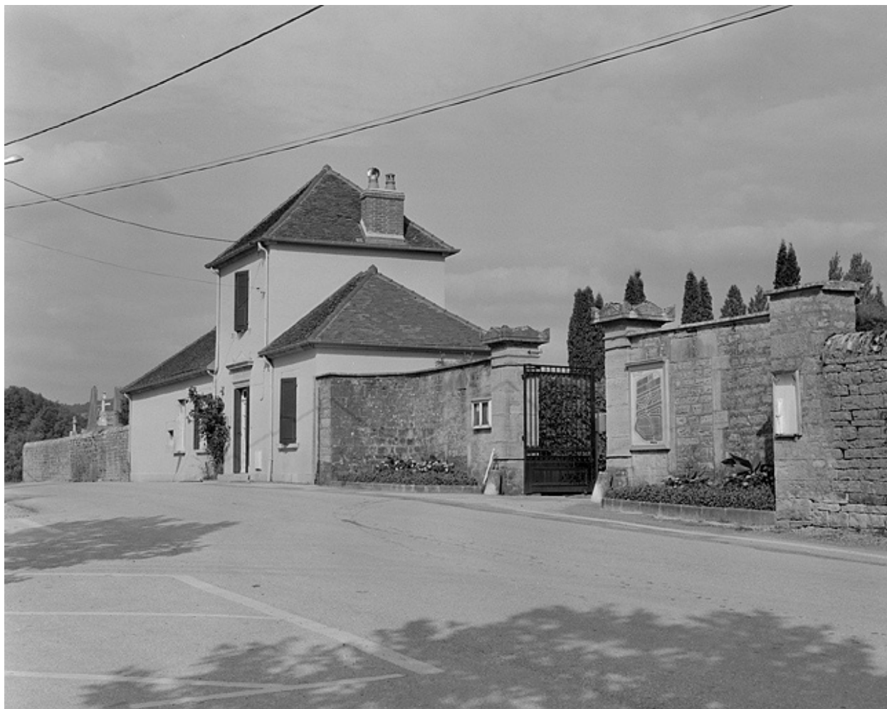
Portail d'entrée et maison du gardien.
