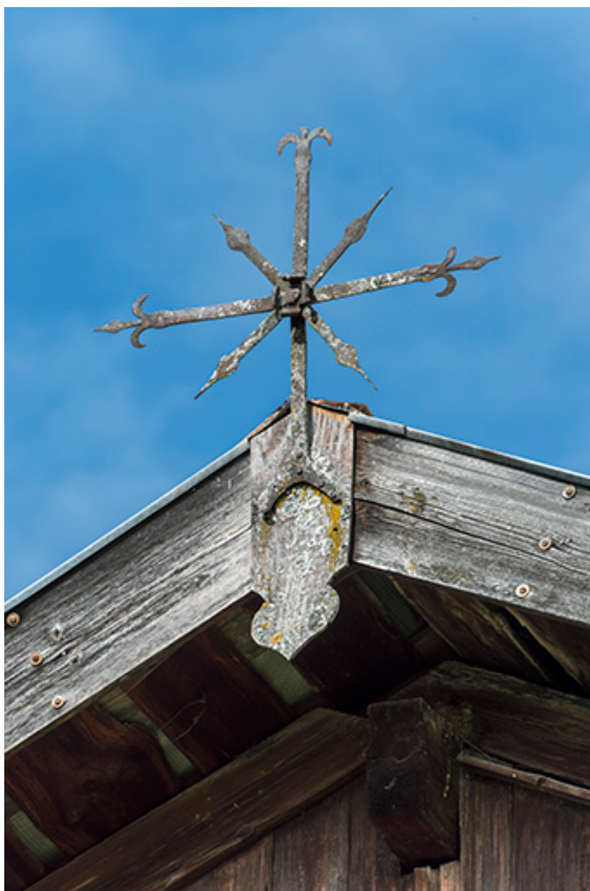
Façade antérieure : croix de faîtage.
