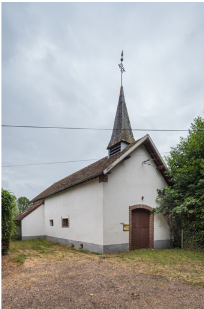
Vue des façades est (antérieure) et sud.
