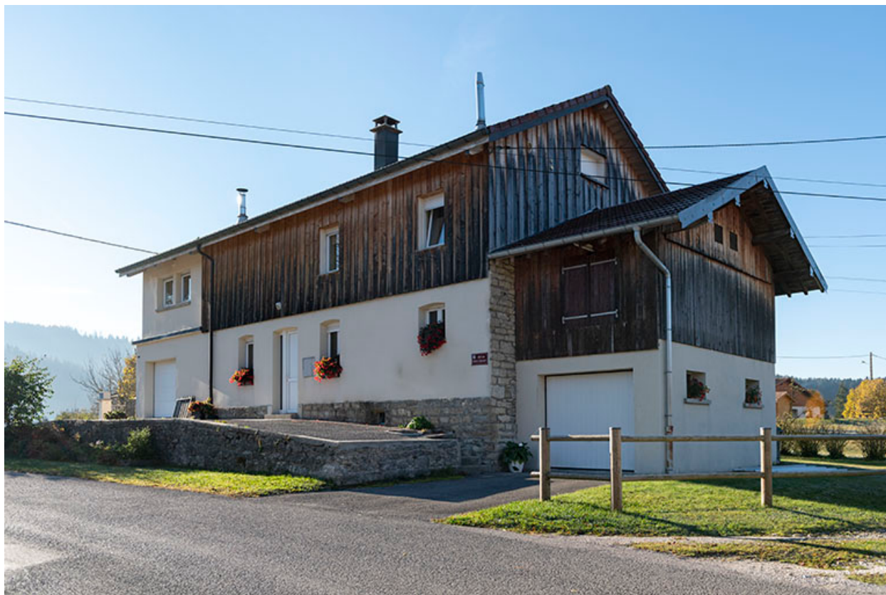
Façades antérieure et latérale droite.
