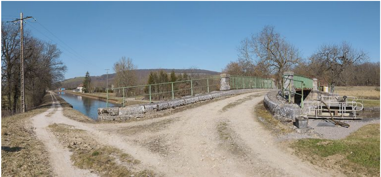
Le pont sur écluse vu d'amont.
