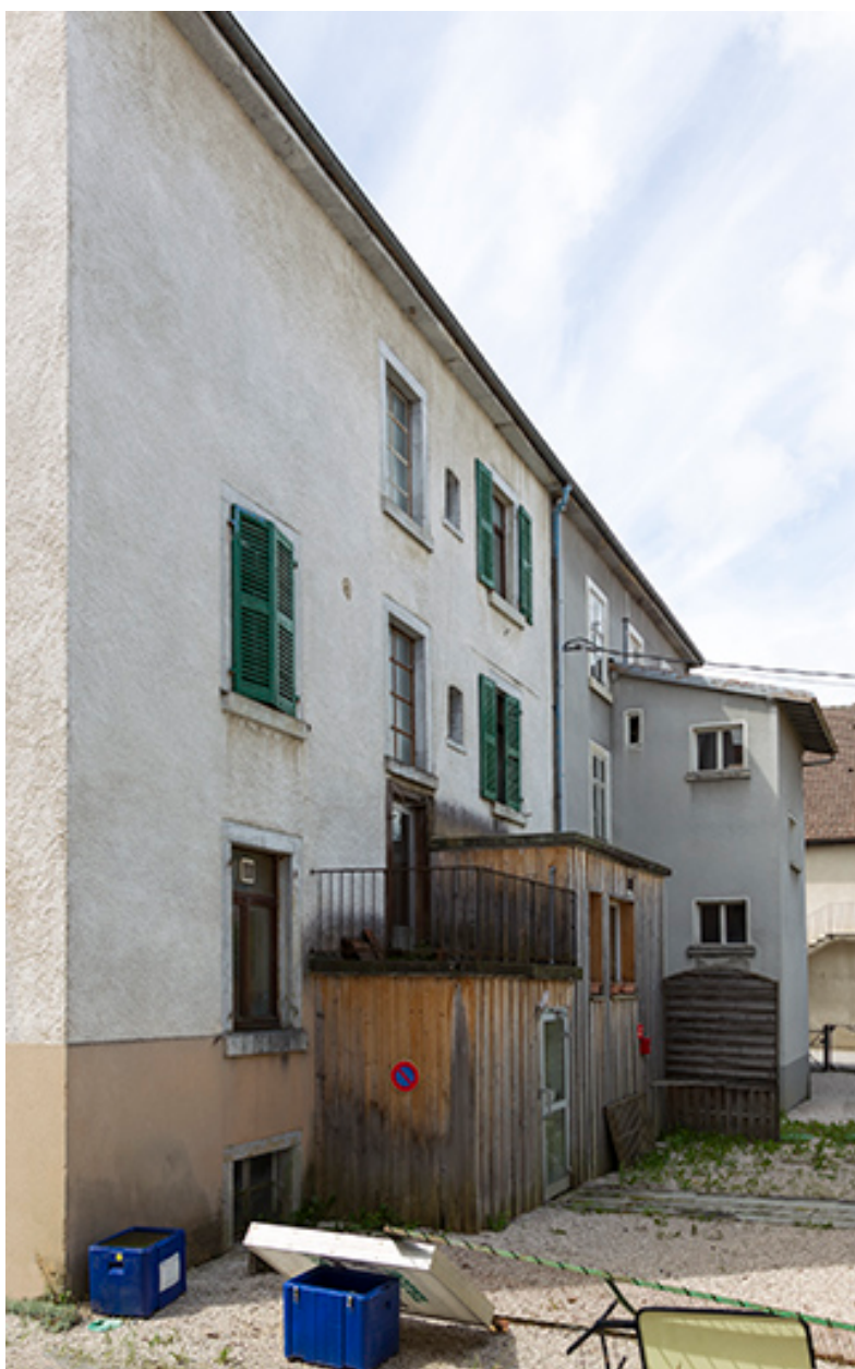
Façade postérieure, vue en enfilade.
