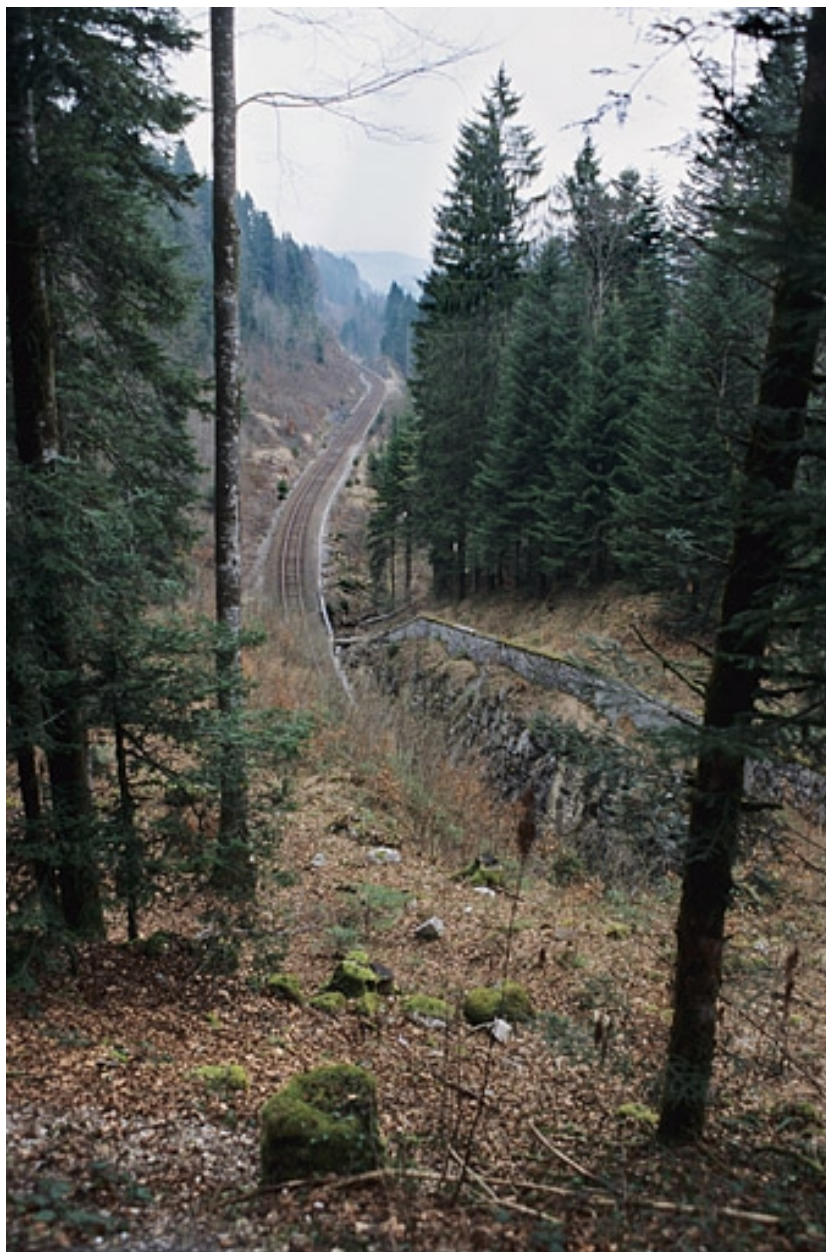
Tranchée et mur de protection côté Andelot-en-Montagne.
