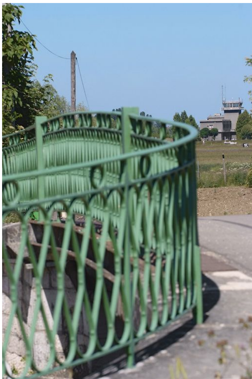
Détail du garde-corps en ferronnerie.
