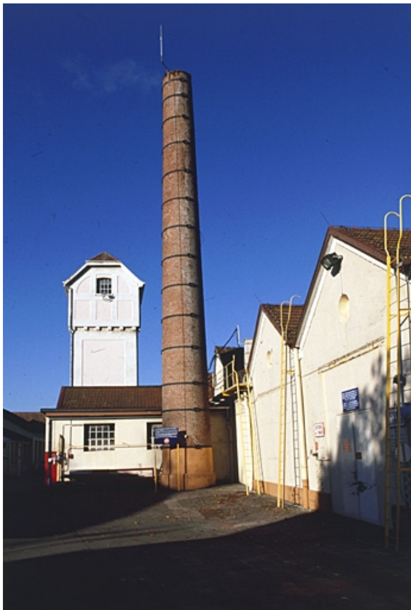
Réservoir industriel, cheminée et entrepôt industriel.
