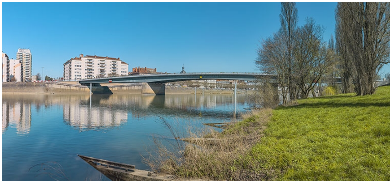
Vue d'ensemble du pont, prise d'aval.
