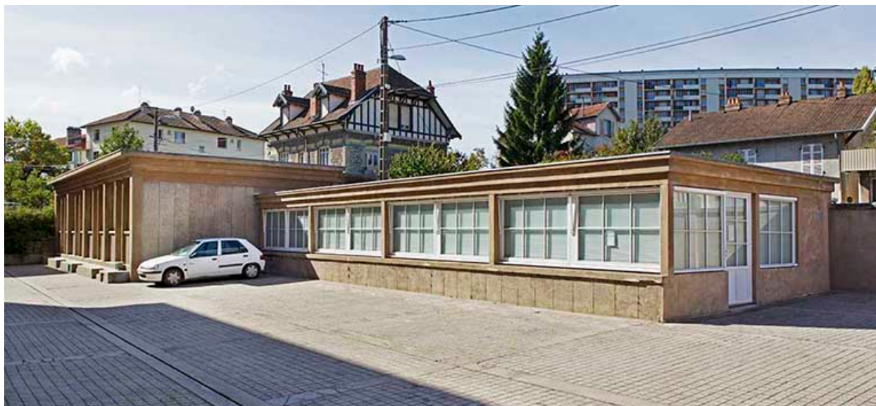
Garages : façades antérieure et latérale droite.
