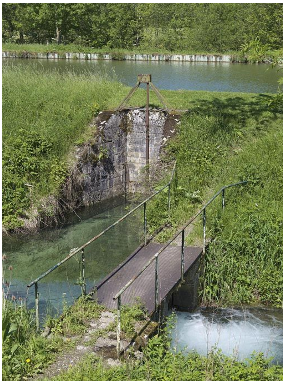
Aqueduc et déversoir régulant l'eau du bief 21.
