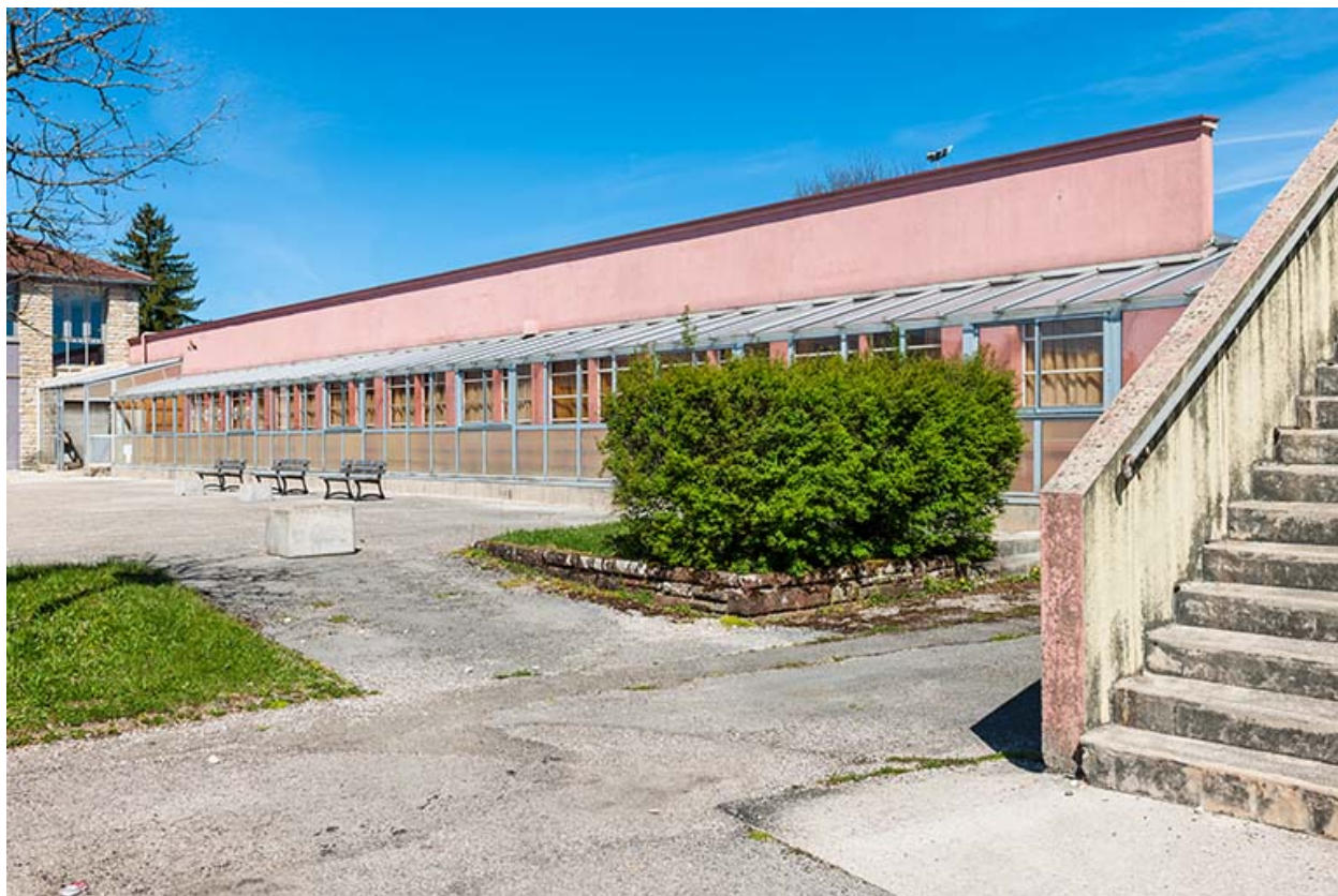
Atelier, site avenue Edouard Herriot : façade antérieure.
