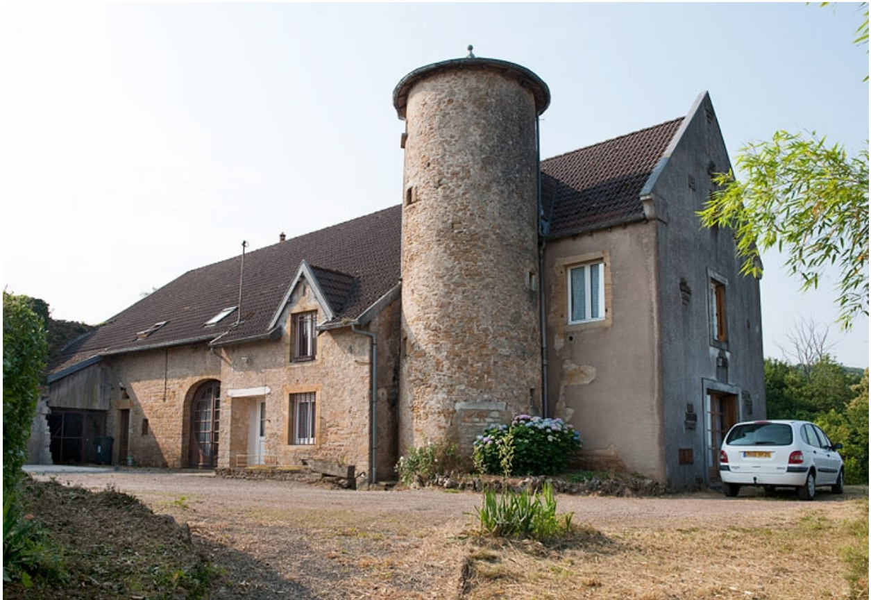
Façade antérieure, vue de trois quart droit.
