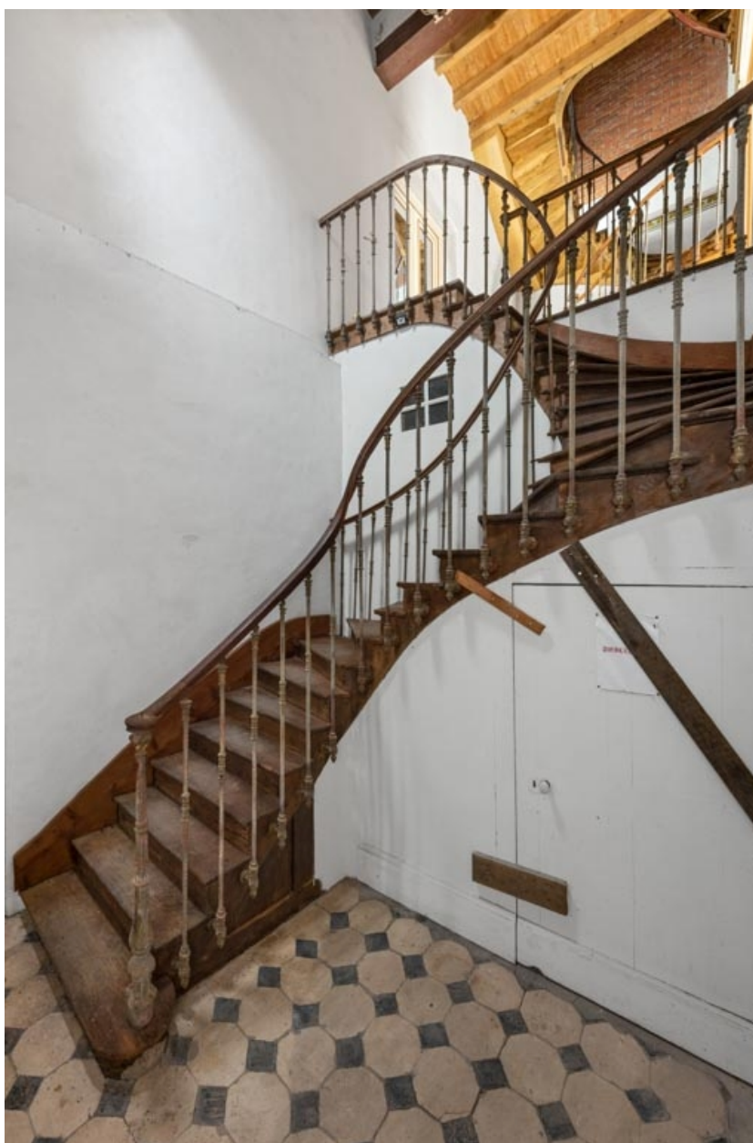
Corps sud : escalier desservant le 1er étage.
