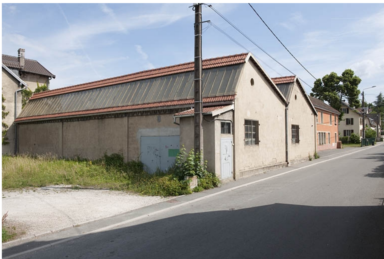
Atelier de fabrication. Extension occidentale.
