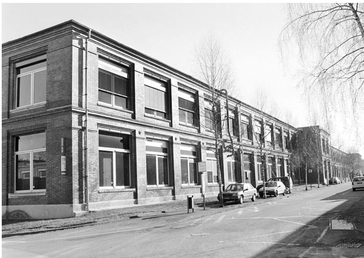
Atelier de finissage : façade ouest.
