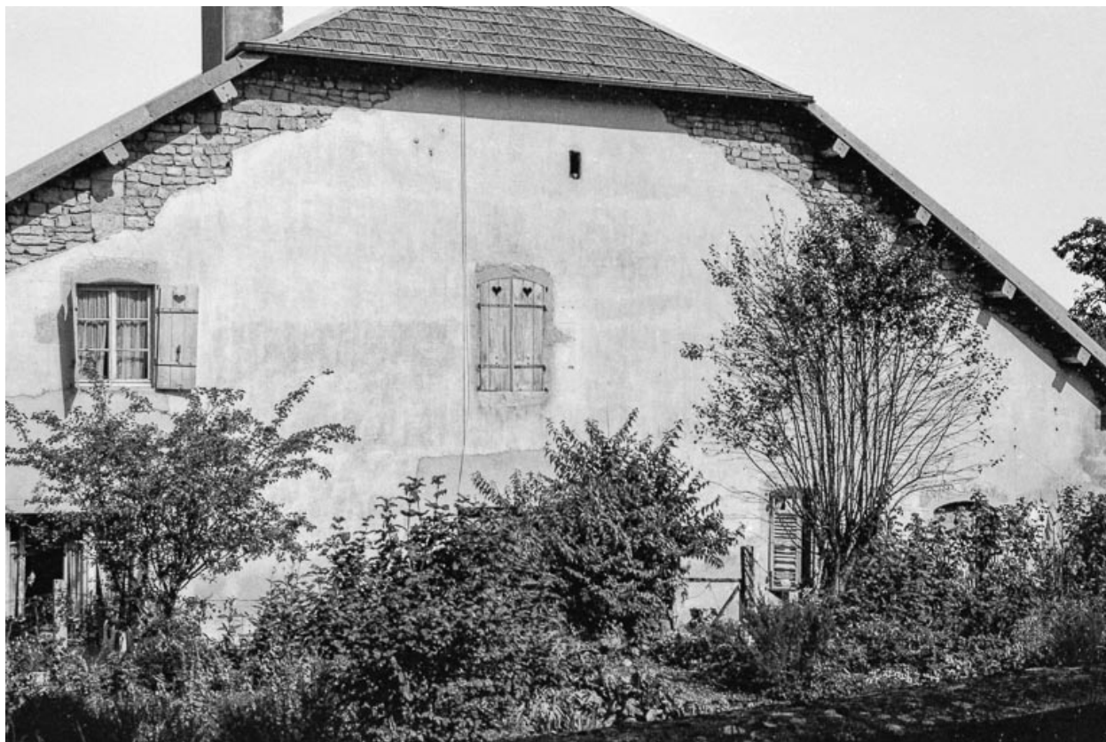
Ferme cadastrée 1961 AC 107 : façade antérieure.
