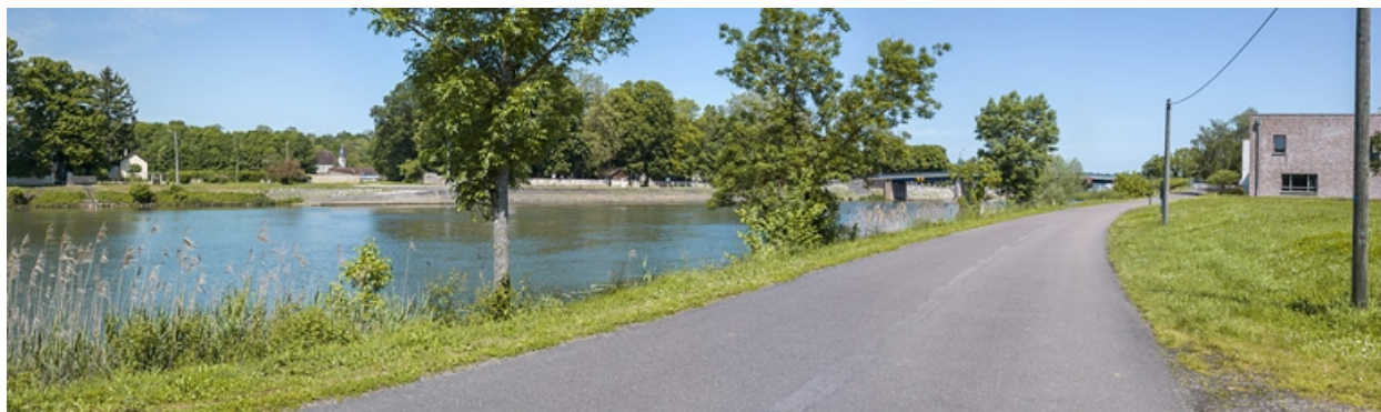
Vue d'ensemble depuis la rive gauche.
