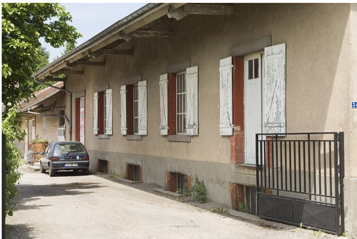
Façade du chai, à l'entrée.
