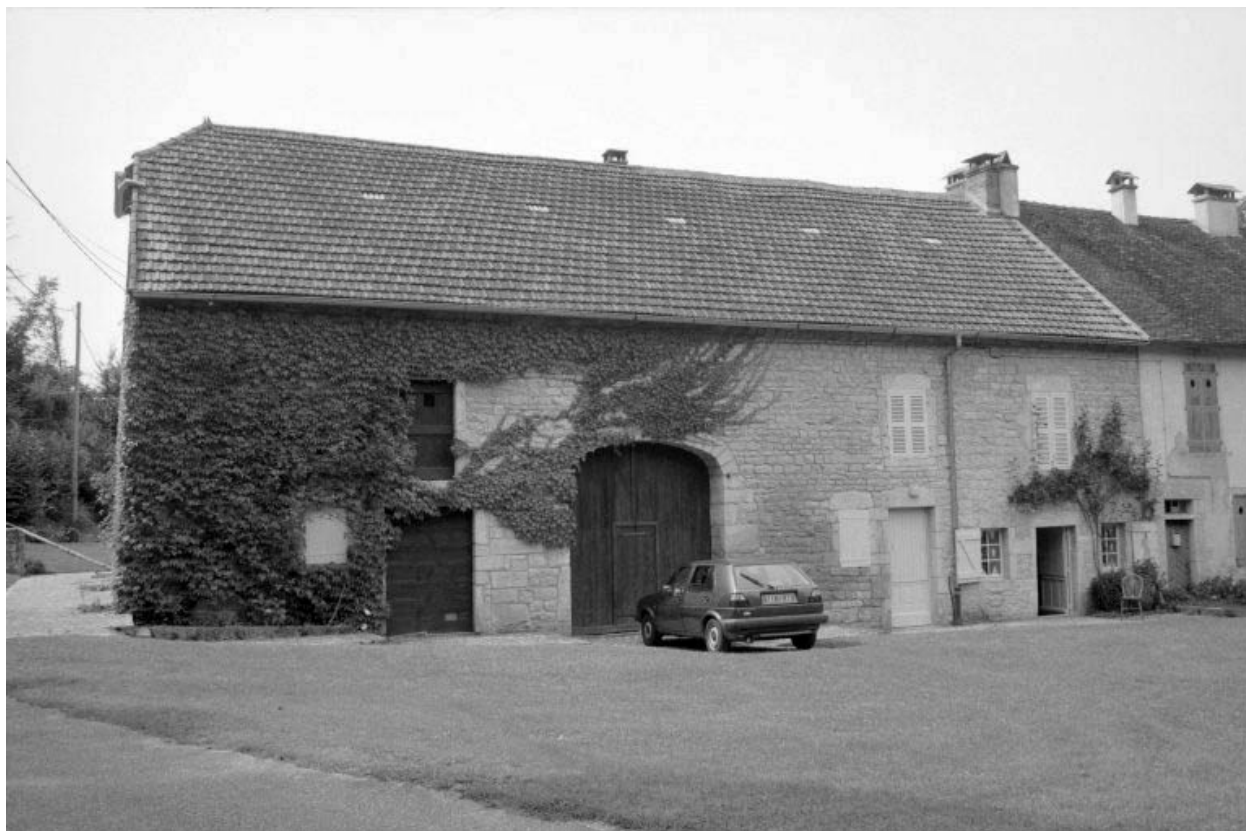
Façade postérieure de l'étable.
