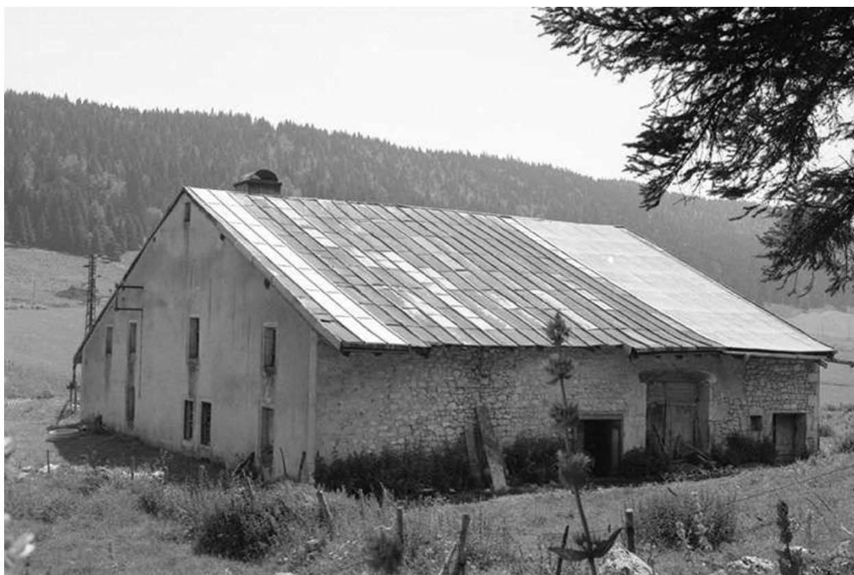
Façades postérieure et latérale droite.
