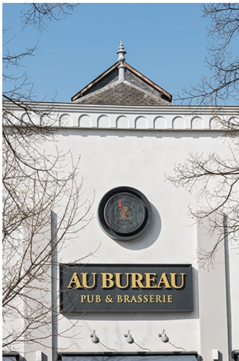
Façade antérieure : décor de la travée centrale.
