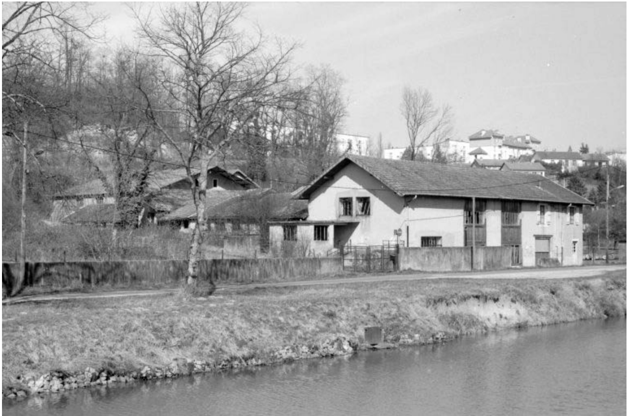
Ateliers de fabrication et logement d'ouvriers.
