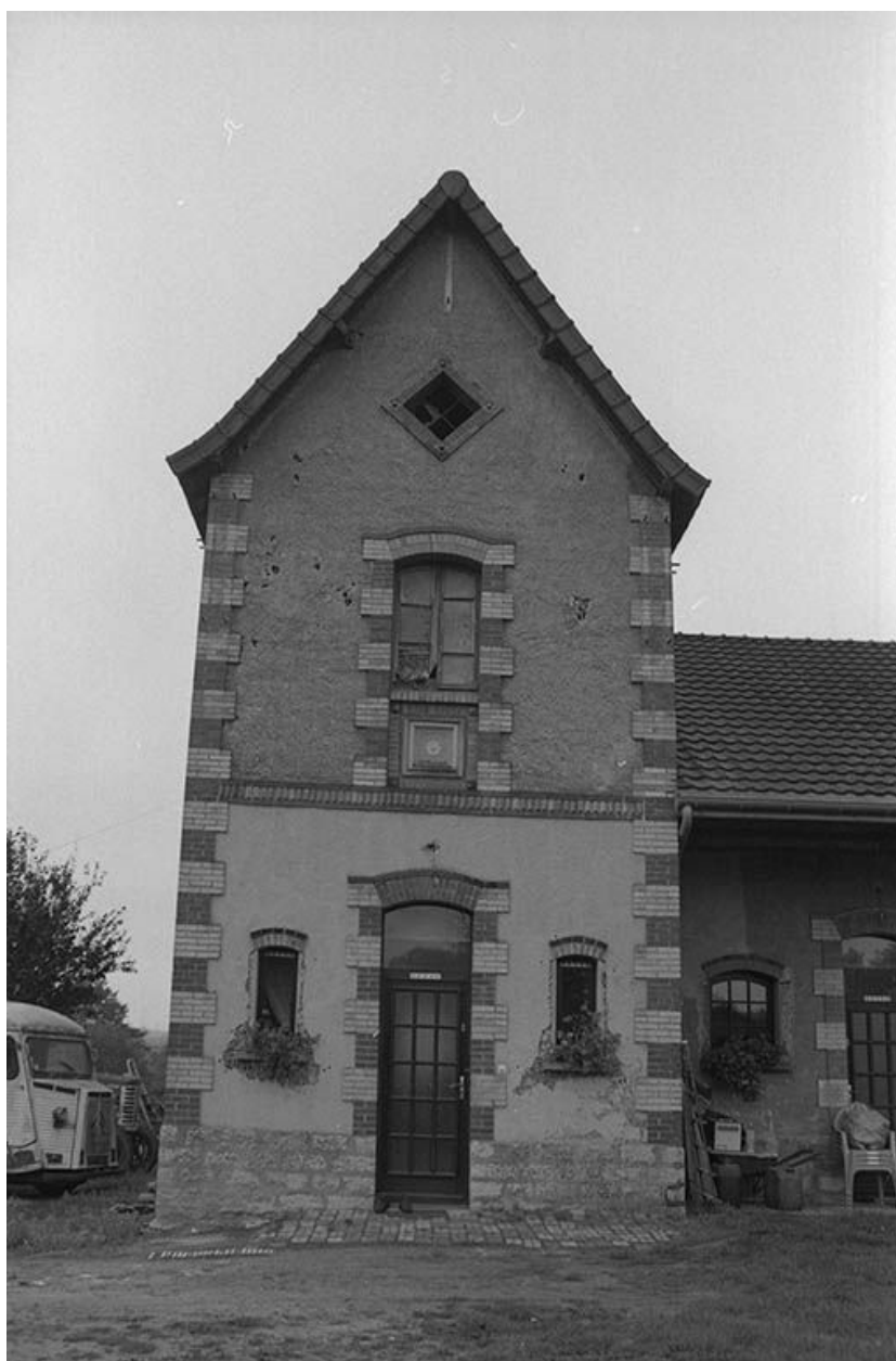
Pavillon sud, façade est.
