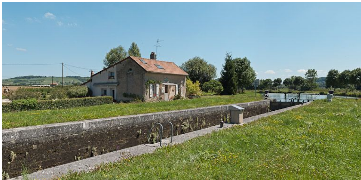
Vue d'ensemble du site d'écluse.
