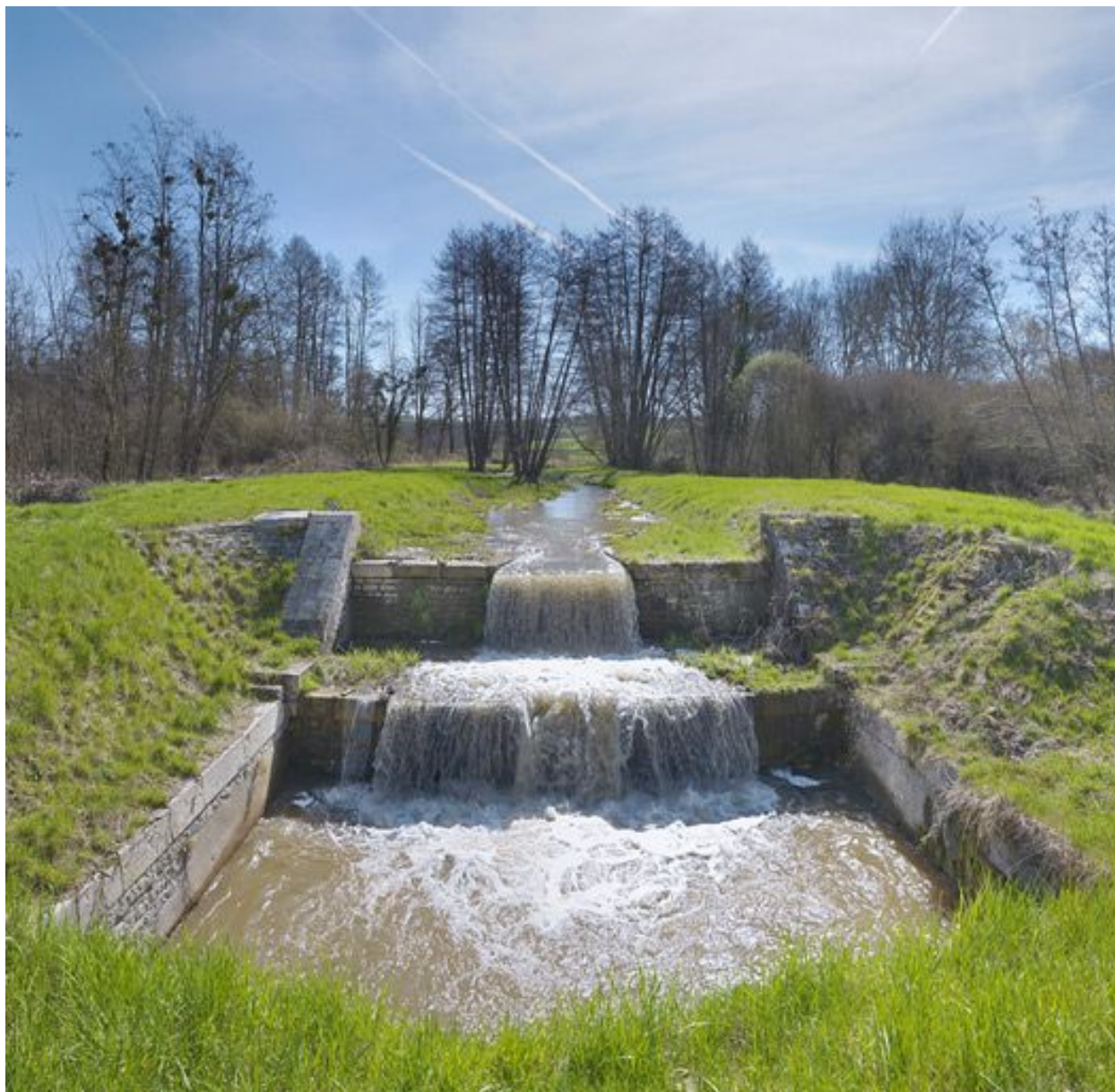
Palier et bassin de décantation avant le passage sous le canal.
