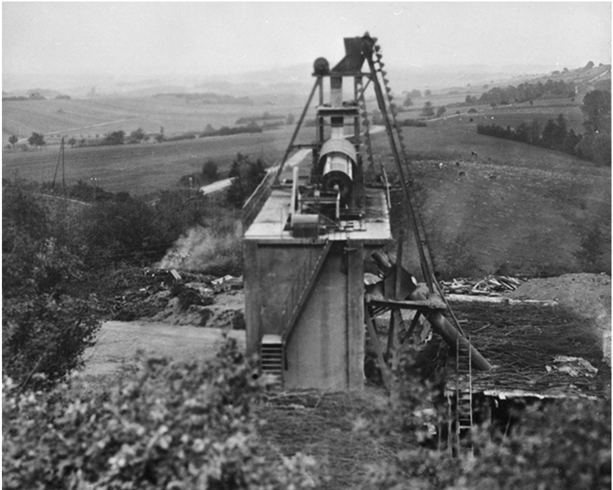
Installation de triage après concassage, 1931.
