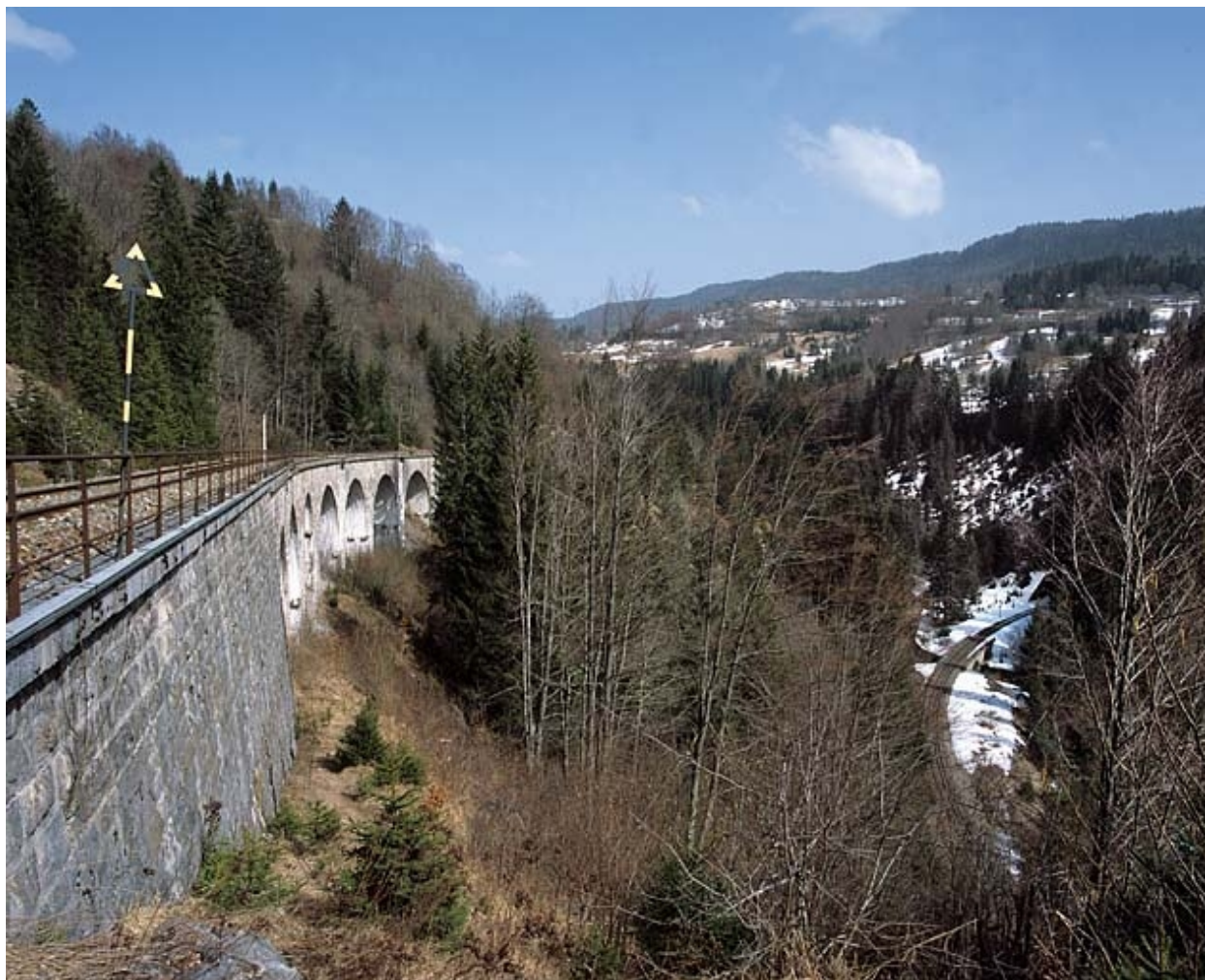
Vue d'ensemble, depuis le sud-ouest (côté Andelot-en-Montagne).
