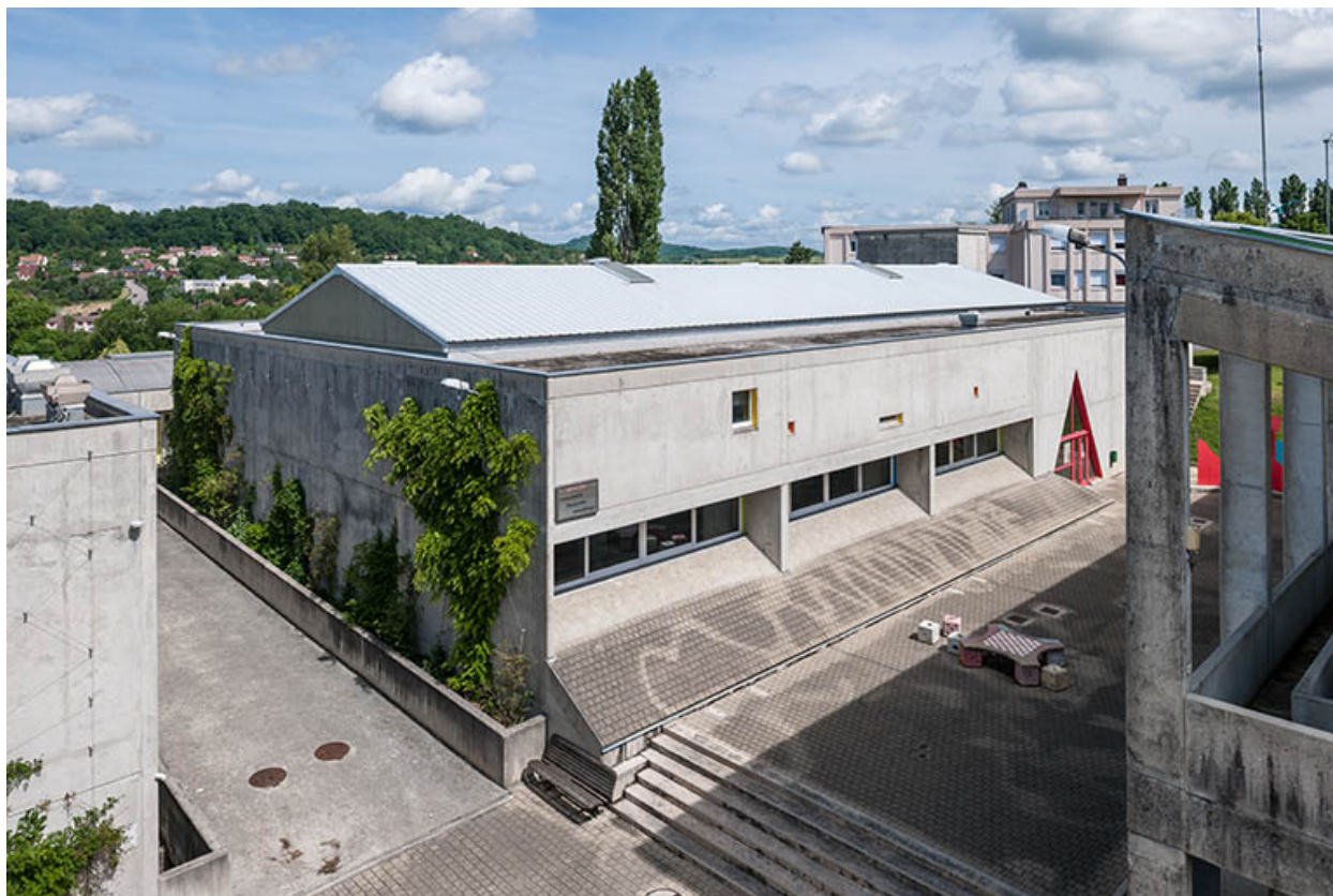
Atelier bois : vue générale
