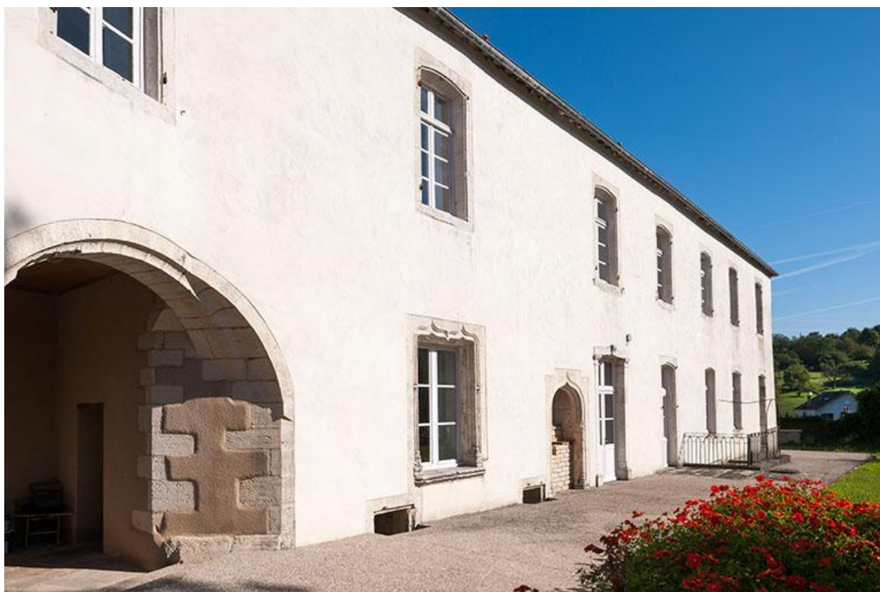
Vue sud-ouest du logis
