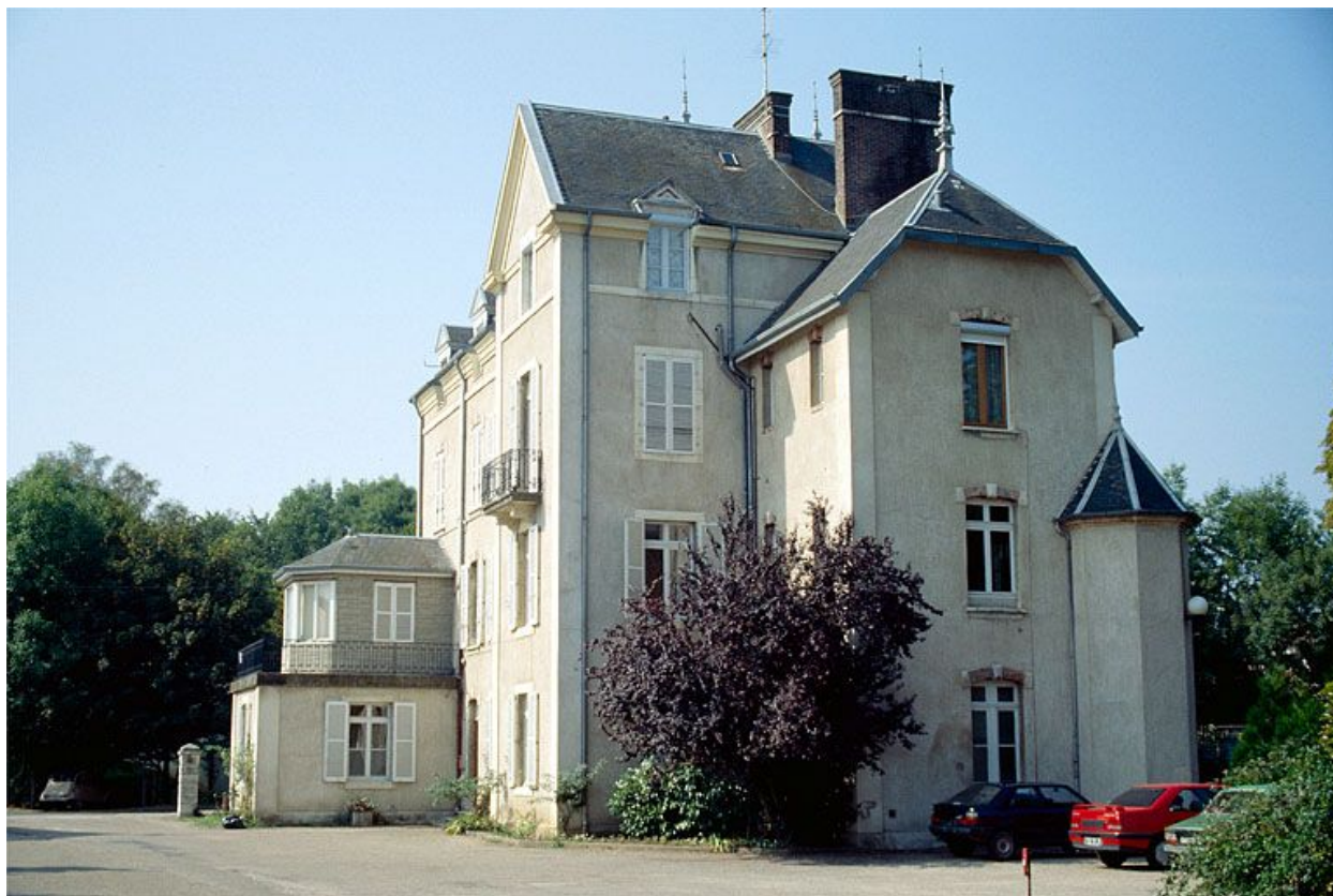
Façade latérale gauche du logement patronal (A).
