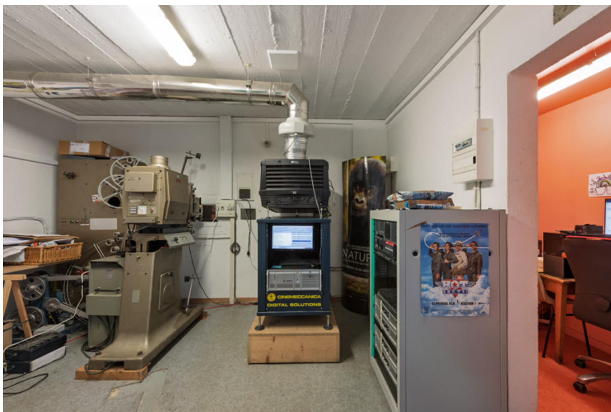
Nièvre, Saint-Honoré-les-Bains. Salle paroissiale Saint-Loup puis cinéma Select : la cabine de projection.
