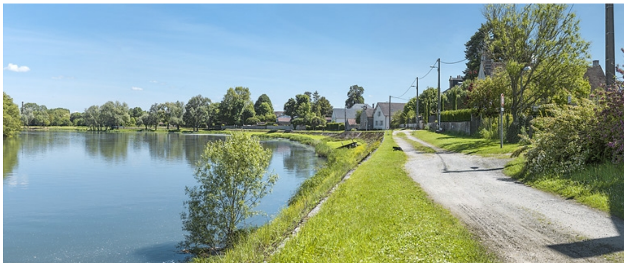
Vue d'ensemble de la digue, prise d'aval.
