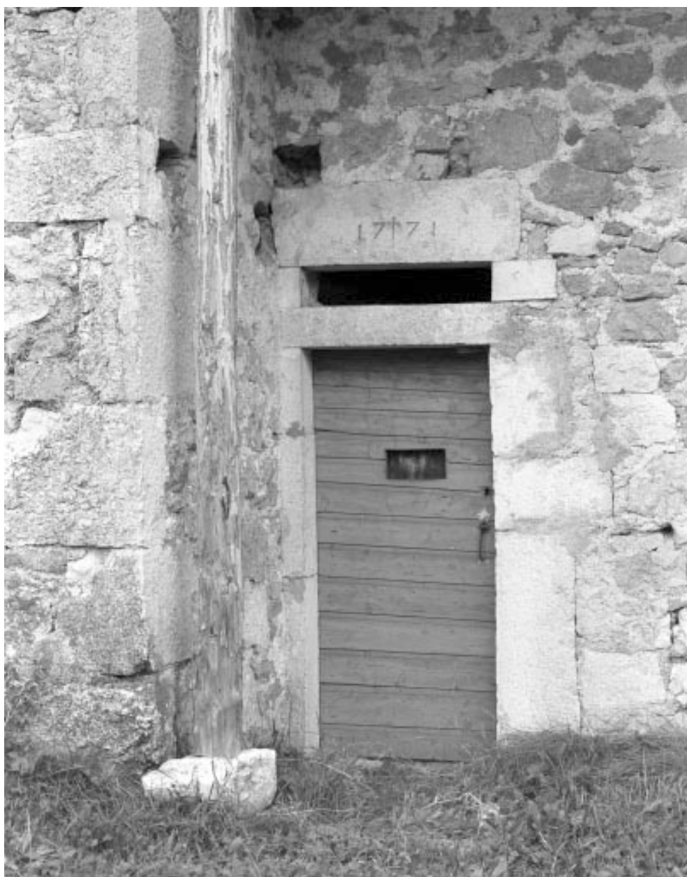
Porte d'accès au logis.
