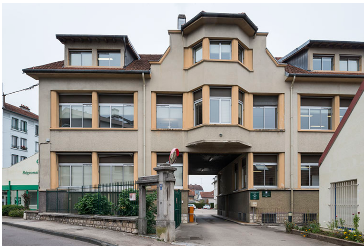
Bâtiment d'entrée. Façade antérieure.
