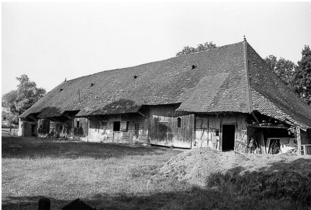
Façade postérieure en 1975.
