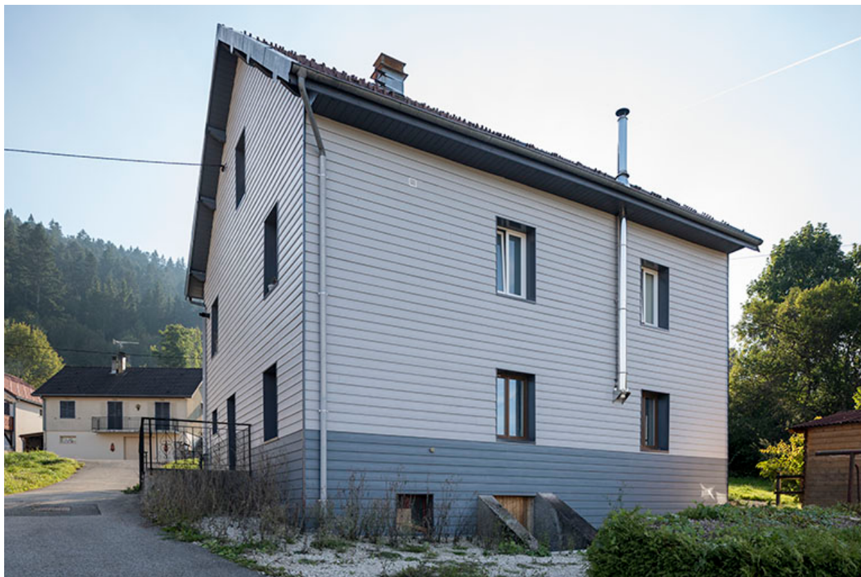
Façades postérieure et latérale droite.
