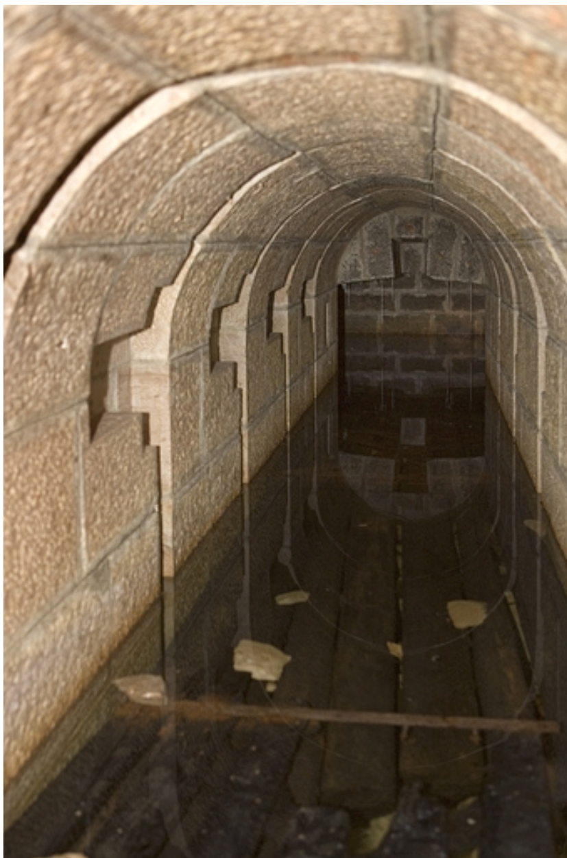
Chambres de mine centrale : galerie inférieure.
