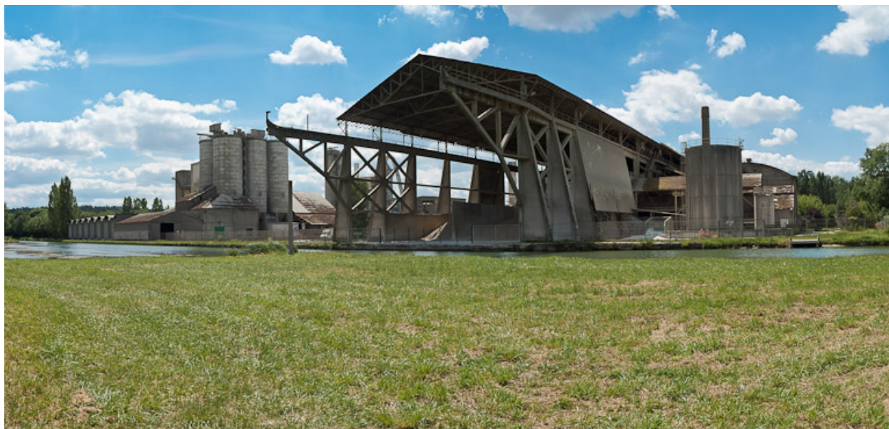
Vue du pont-roulant de la cimenterie.
