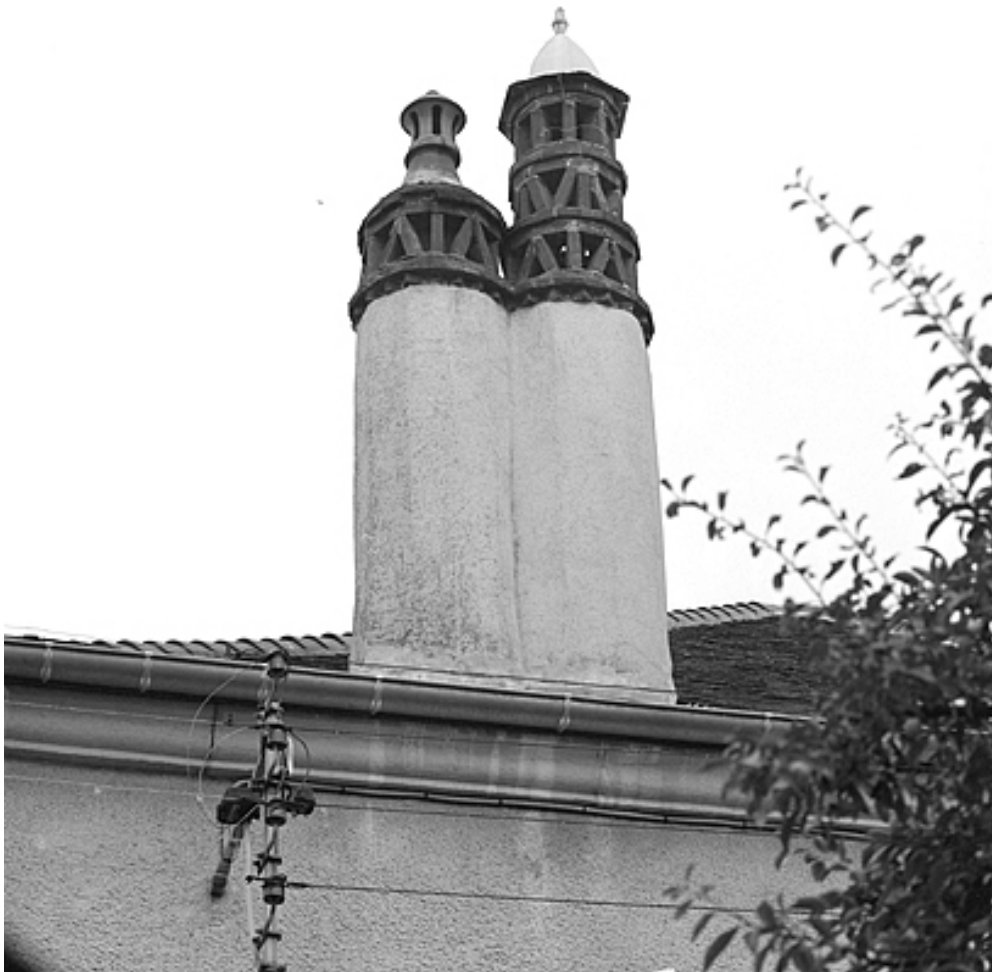
Souches de cheminée.
