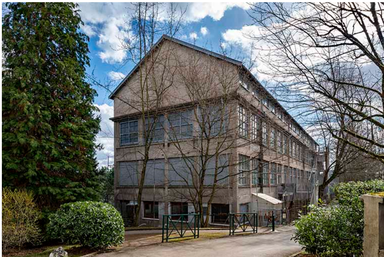
Entrepôt industriel, vu depuis le nord.
