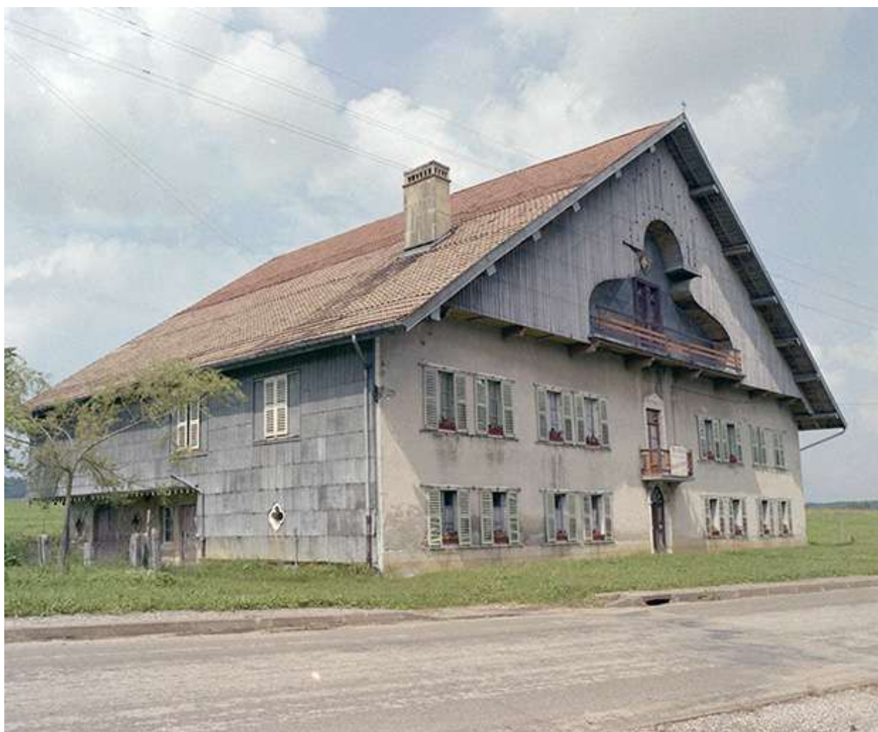
Façades antérieure et latérale gauche.
