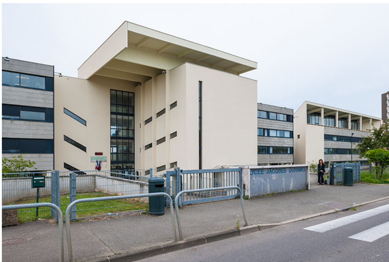
Entrée principale : détails.
