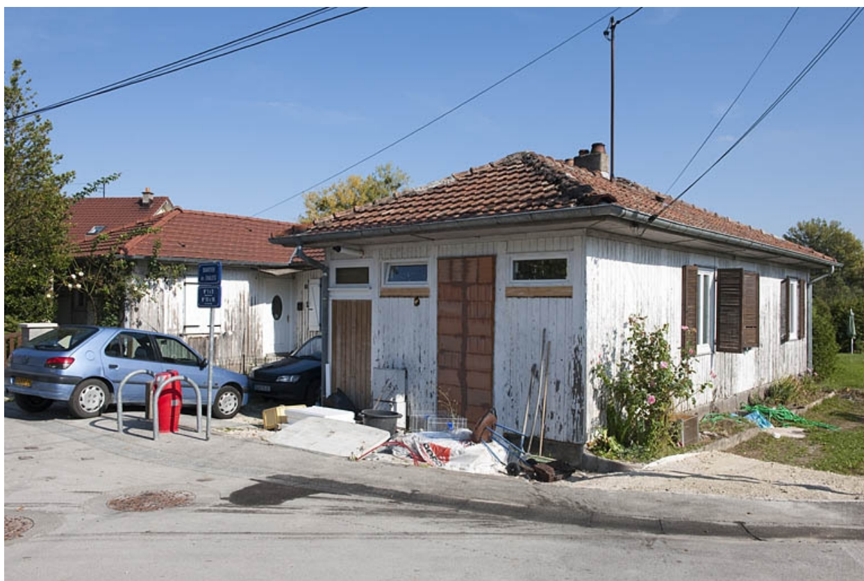
Maison jumelée (n°8-10) vue de trois quarts.
