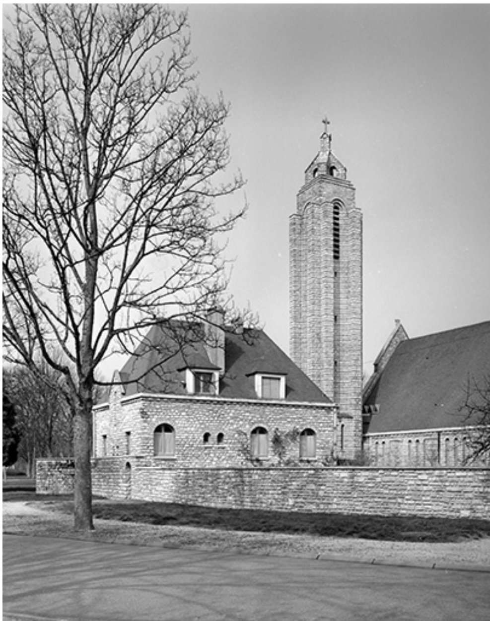
Face postérieure du presbytère et tour-clocher.
