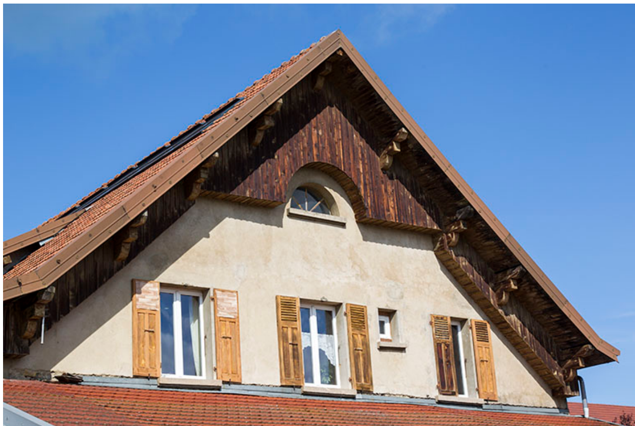
Façade postérieure : fenêtres du pignon.
